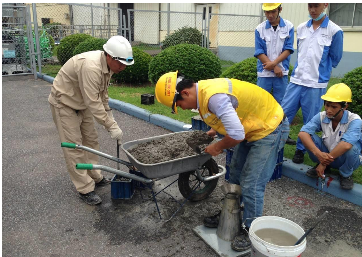
Kiểm tra độ sụt bê tông tại hiện trường
