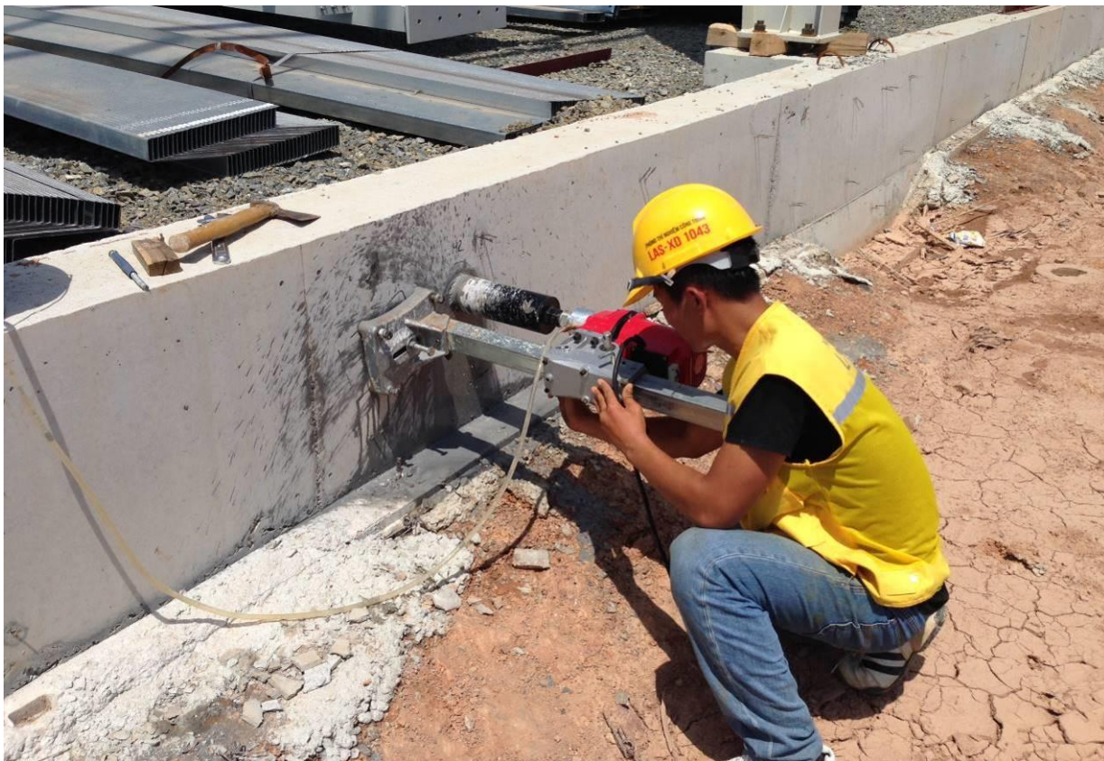
Kiểm tra chất lượng bê tông dầm móng bằng phương pháp khoan lấy mẫu
