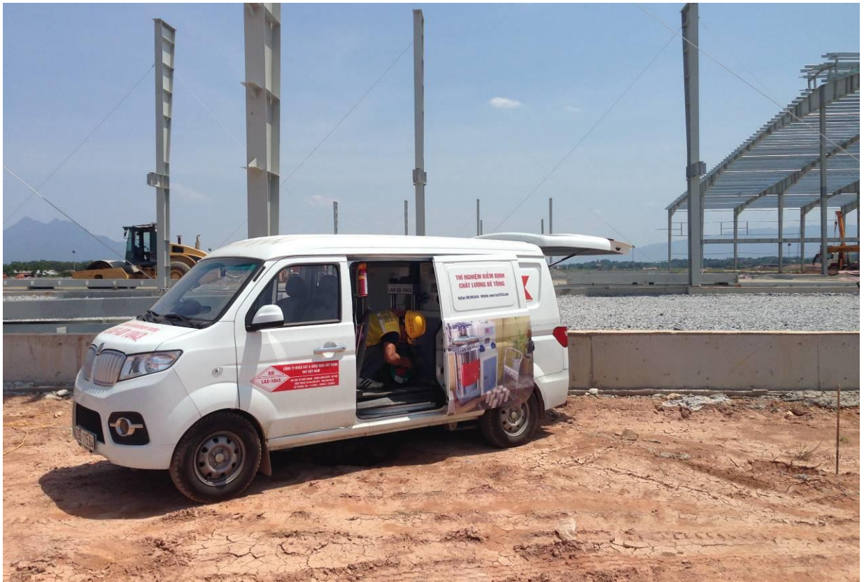
Nén kiểm tra cường độ bê tông ngay tại công trường bằng xe thí nghiệm lưu động
